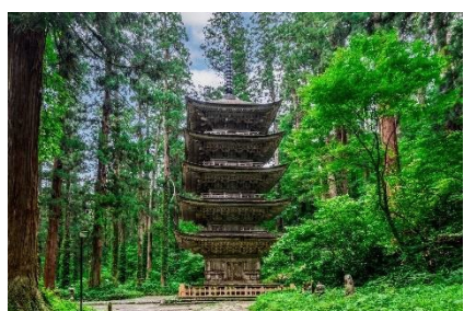
羽黒山五重塔（鶴岡市）
